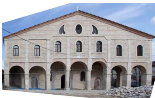
Εικόνα 10: Κύρια όψη του ναού μετά την αναγωγή. Πηγή: Ιδία Επεξεργασία.
