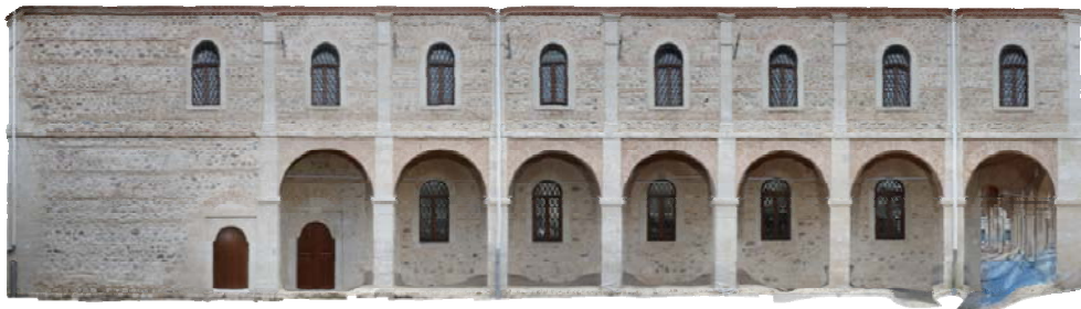
Εικόνα 4: Βόρεια Όψη Ιερού Ναού (Πλάγια Όψη). Πηγή: Ιδία Επεξεργασία.
